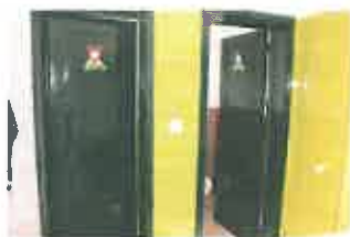
Requalificação dos WC na Eb1 Vale Madeiros
