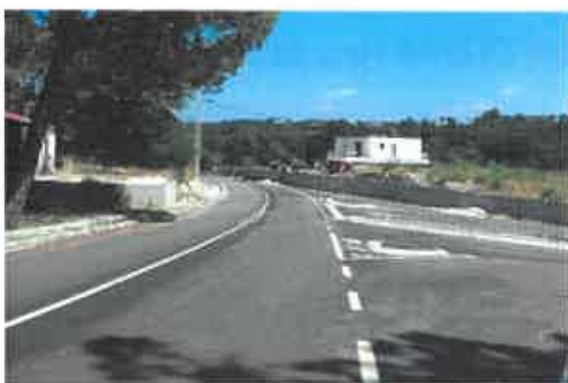
Figura 76 - Requalificação Estrada Mun. Moreira - Nelas
