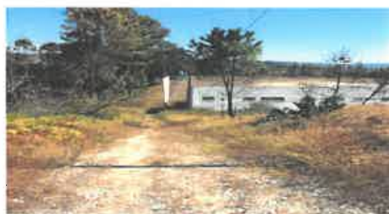
Figura 92 - Requalificação Estádio Vale de Madoiros
