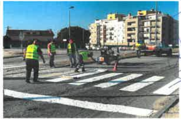
Figura 95 - Pintura sinalização horizontal pelo concelho
