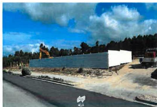
*Figura 80 – Reservatório 4000 m3 de água*
