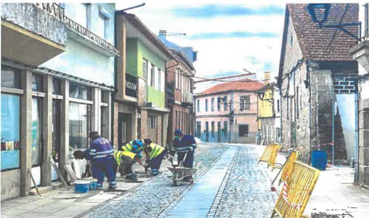
Reparações na Rua Gago Coutinho – Nelas
