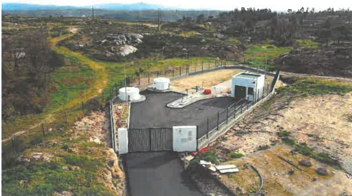
Conclusão/Entrada em funcionamento da Nova ETAR da Lapa do Lobo
