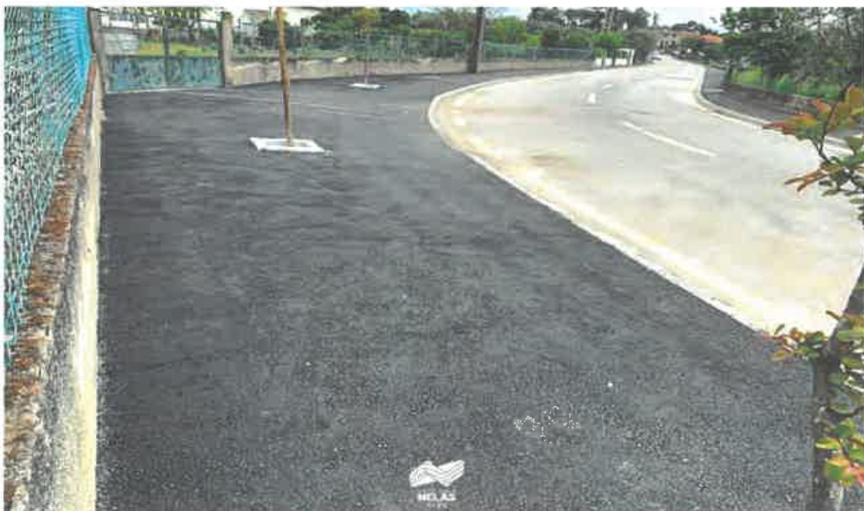
Construção de passeios na Rua do Castelão – Lapa do Lobo
