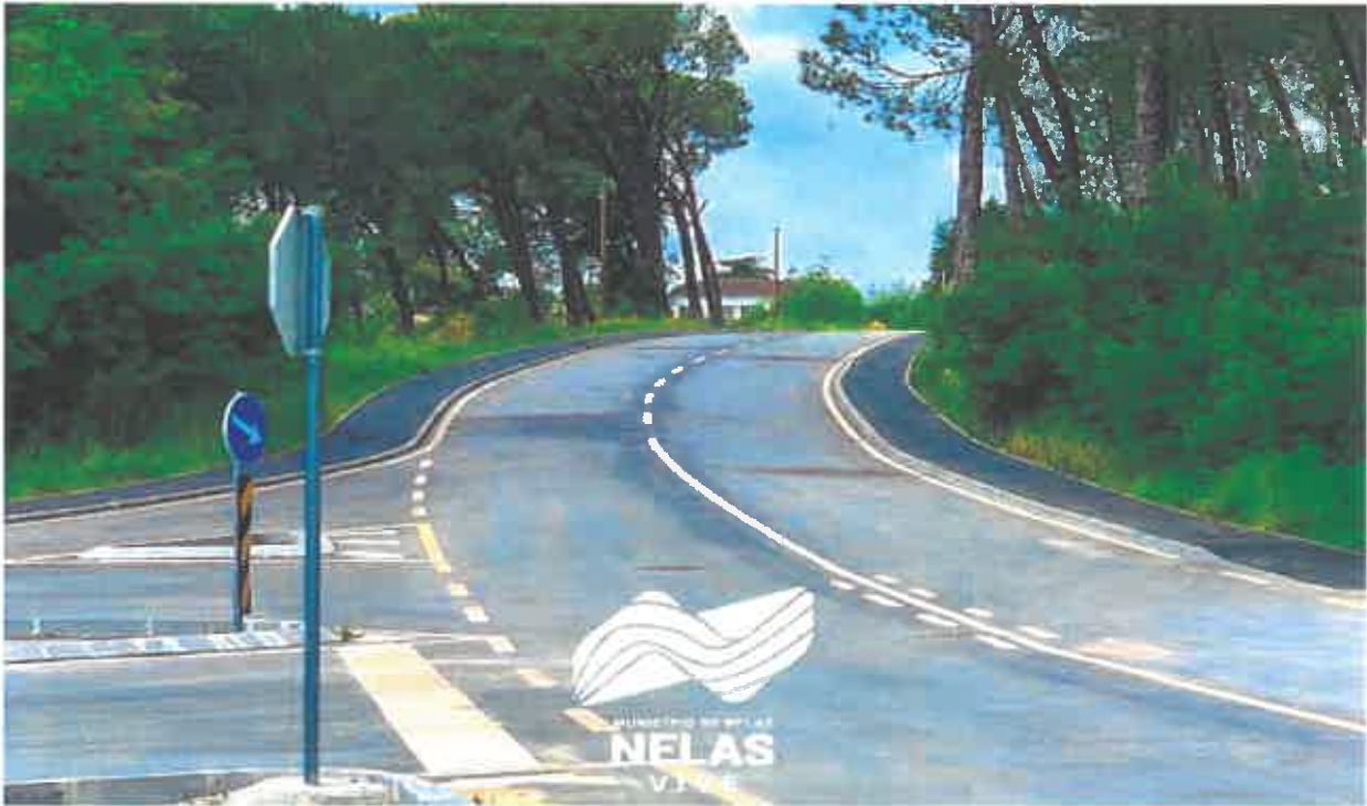
Construção de passeios na nova Estrada Municipal Moreira/Nelas
