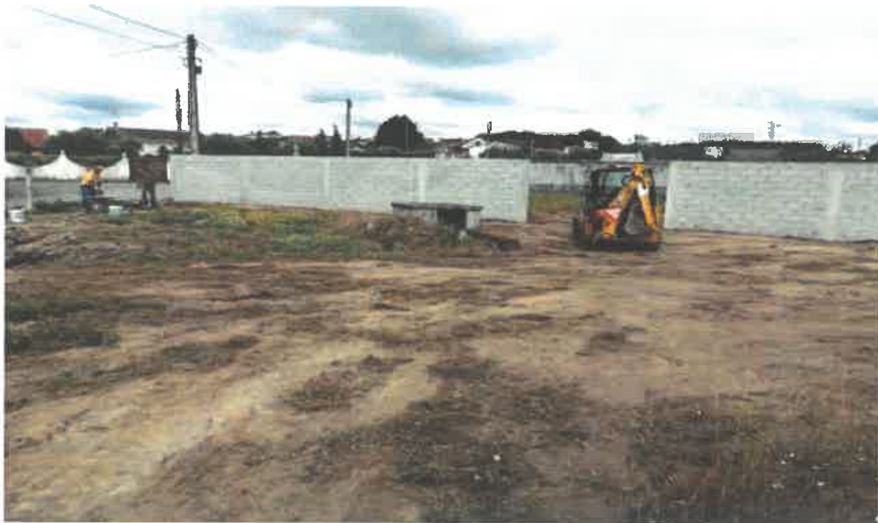
Ampliação e requalificação do Cemitério de Senhorim
