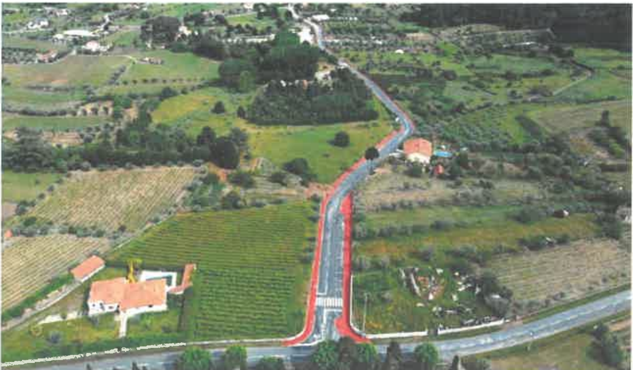
Construção de passeios na Avenida da Soma - Santar
