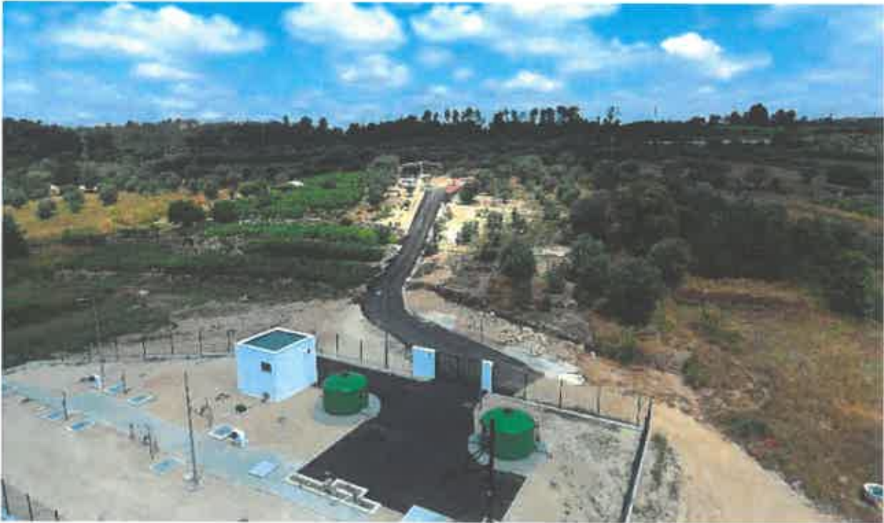
Conclusão/Entrada em funcionamento da Nova ETAR de Vilar Seco
