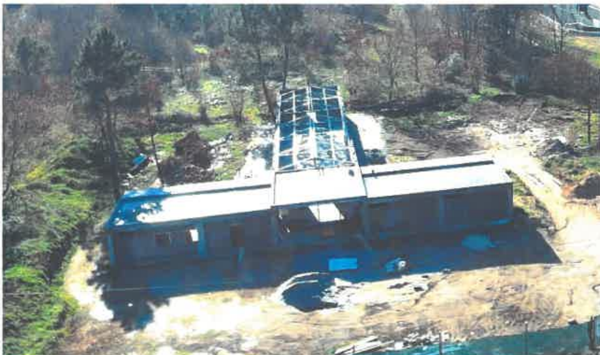
Construção do Canil Municipal (CRO – Centro de Recolha Oficial de Animais)
