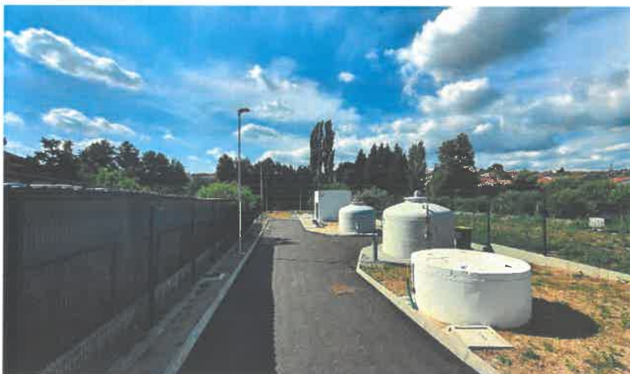
Conclusão/Entrada em funcionamento da Nova ETAR de Moreira
