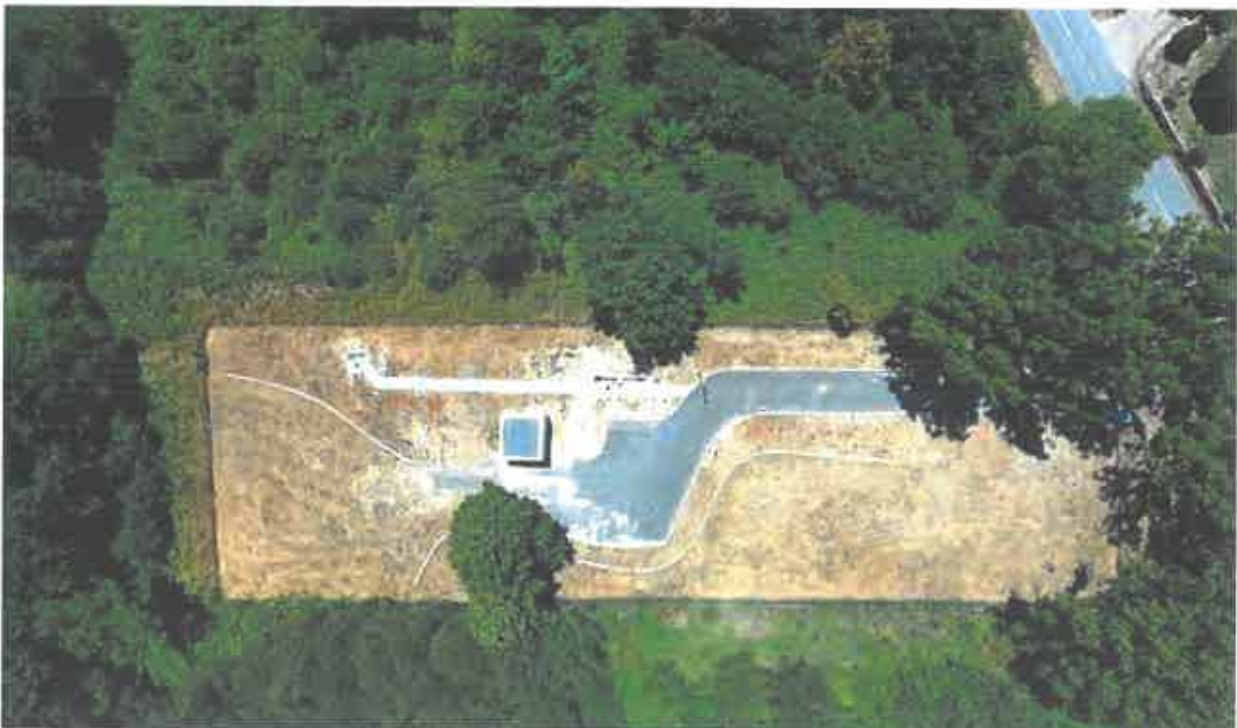
Entrada em funcionamento da Nova ETAR de Santar
