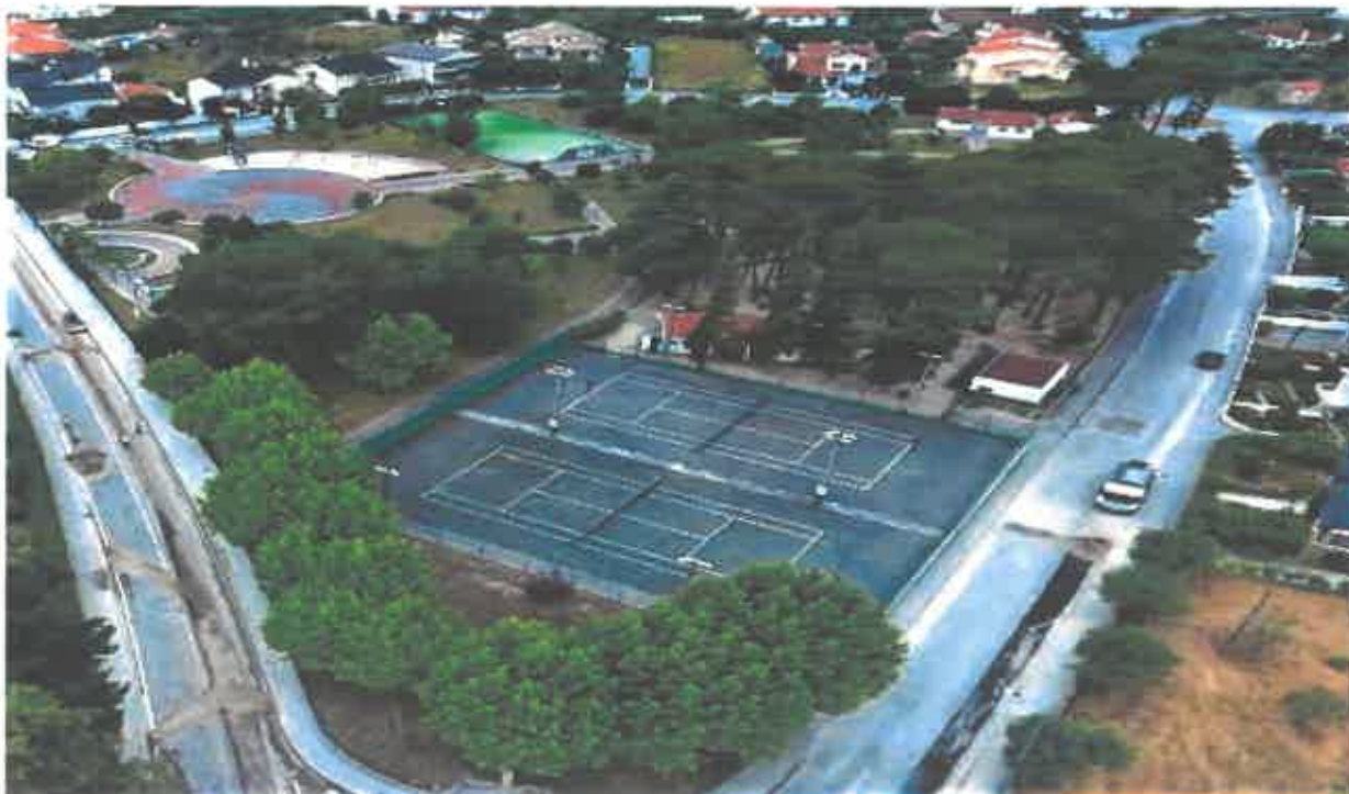
Início das obras de requalificação do Parque de S. Miguel/Mata das Alminhas - Nelas
