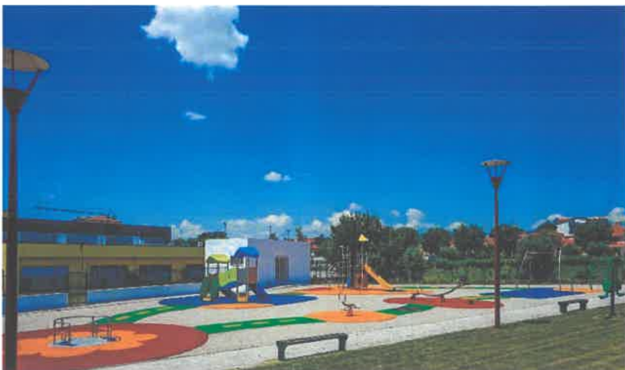
Construção de parque infantil – Nelas
