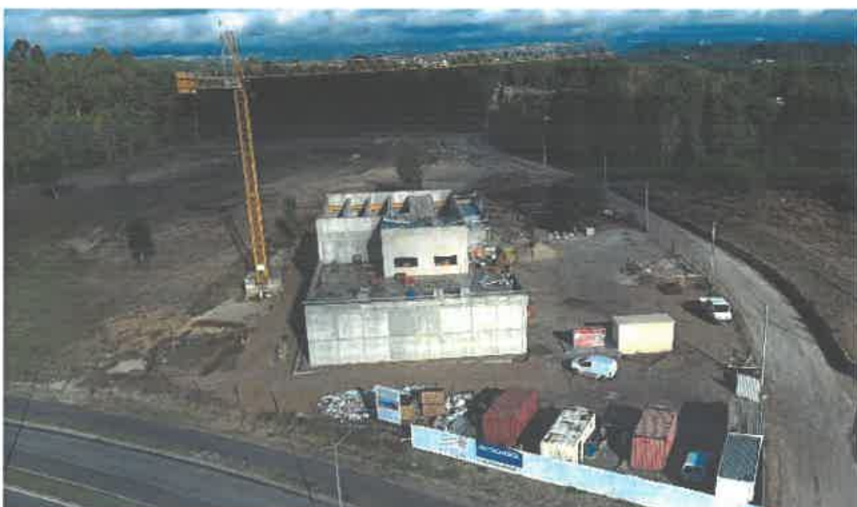
Continuação da construção do grande Reservatório de 4000m3 de Água de Nelas
